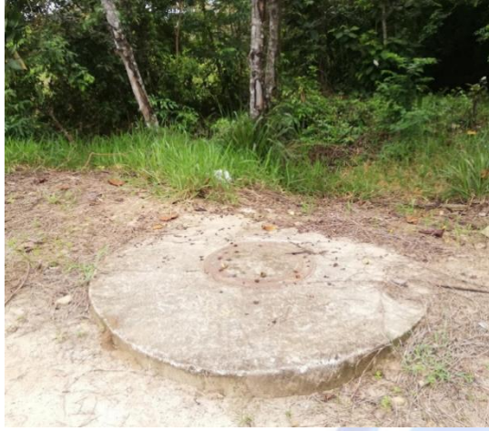
Ilustración 3. Pozo de inspección de red existente de alcantarillado sanitario.
