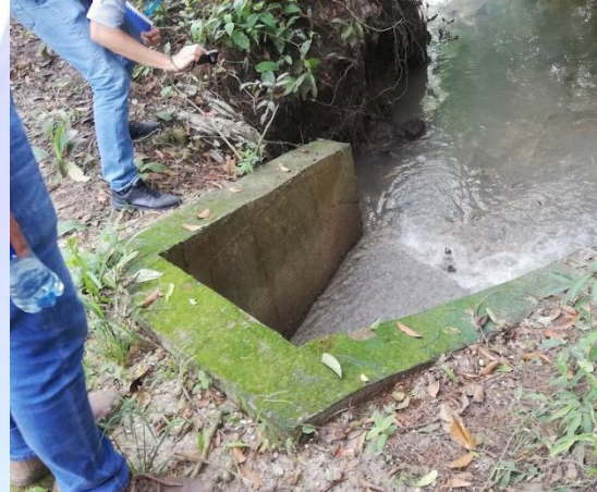
Ilustración 4. Cabezal de descarga existente vertimiento aguas residuales al caño Mojaculo
